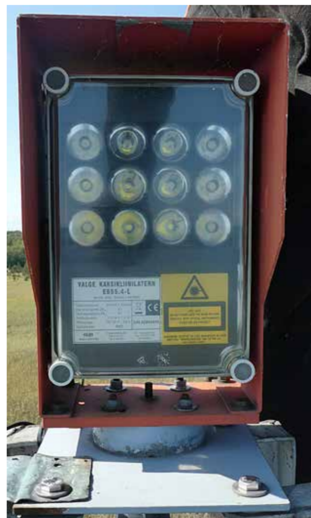
Современный створный фонарь (Sabik E855) нижнего светящегося знака створа Абука, фото 2018 г., Т. Вилу
