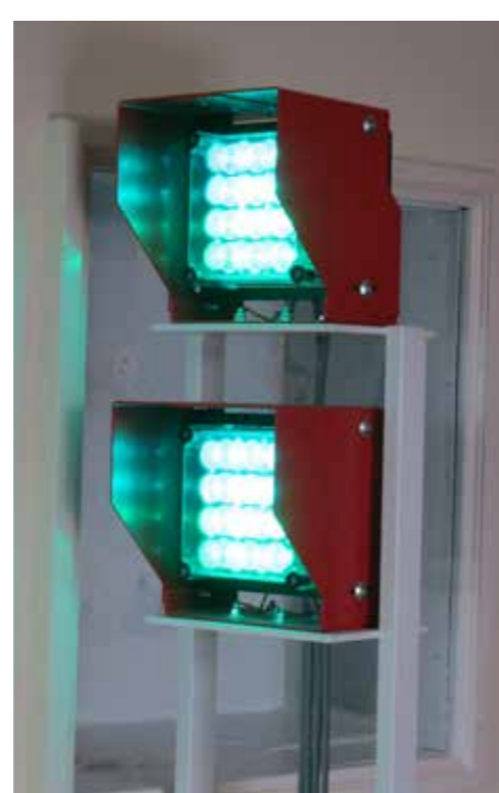
Установленные в 2010 году светодиодные светильники ekta™ E8553 освещают зеленый сектор, фото В. Лайтус
