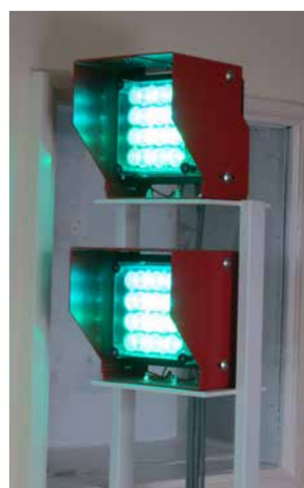
2010. aastal paigaldatud ekta™ E8553 valgusdiodlaternad valgustamas rohelist sektorit, pildistas V. Laitus
