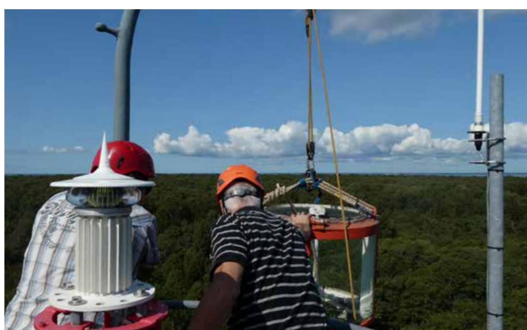
Текущие ремонтные работы на маяке Абука 2018 г., на переднем плане современный светодиодный фонарь, фото Т. Вилу
